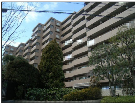
外観：平成24年2月撮影
